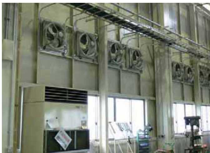
▲工場内の臭気などを除去するために有圧換気扇を設置した。
