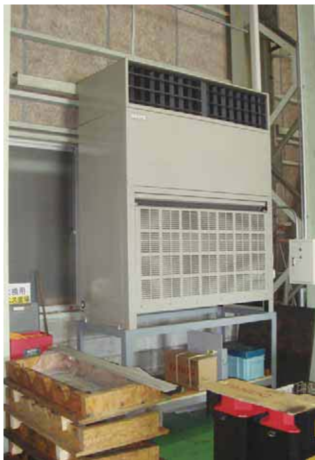
▲ 夏季の酷暑を冷暖房設備を設けることにより作業効率の改善を図った。
