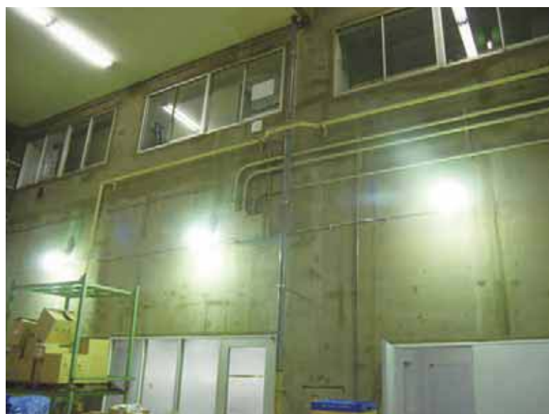
▲天井の高い倉庫の壁面に補助照明を設置して作業者の眼性疲労の軽減を図った。
