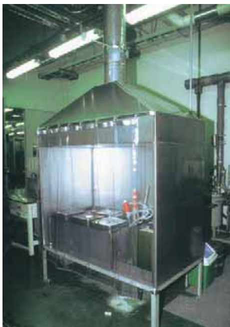
▲有機溶剤の一次置き場においてフードの開口部にビニールカーテンをかけることにより解消した。
