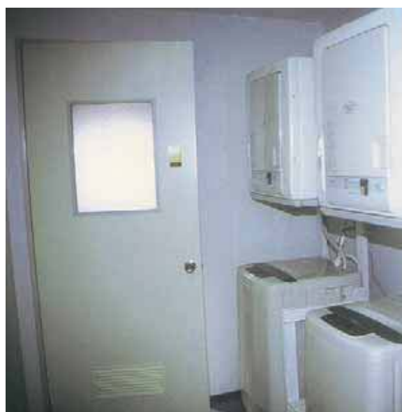
▲ 作業での汚れを落として帰宅できるようにした。洗濯機、乾燥機も設置している。
