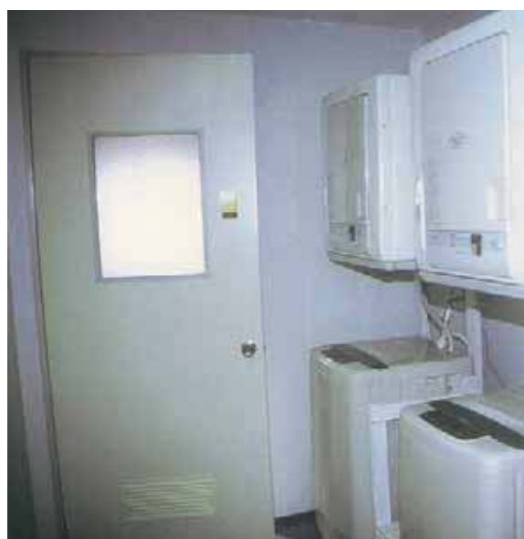
▲ 作業での汚れを落として帰宅できるようにした。洗濯機、乾燥機も設置している。
