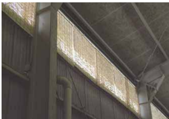
▲ 工場内に入り込む西日対策として、市販の「すだれ」を利用して、見た目にも涼しさを演出
