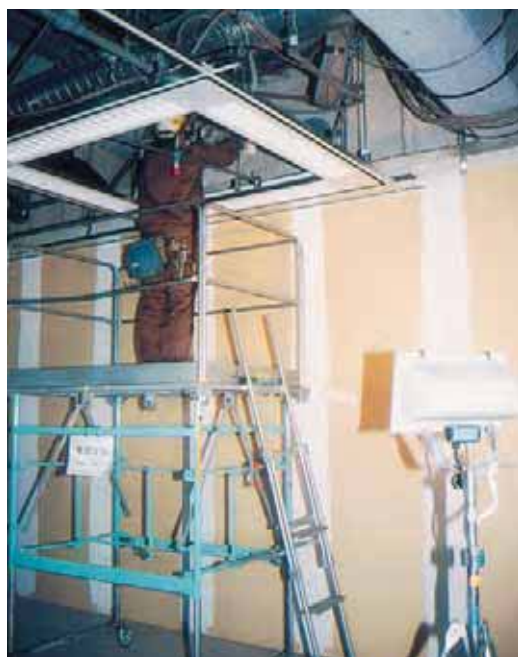
▲手元作業をしやすくするため補助照明として移動式のスポットライトを利用できるようにした。
