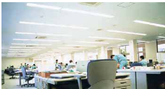
▲事務所の明るさを十分確保し、照明にグレア防止パネルを取り付けた。
