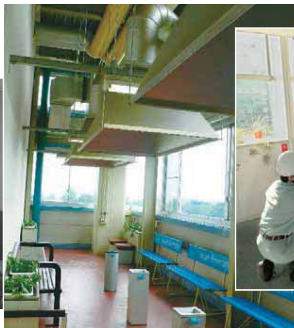
▲ 局所排気装置方式のフードを設置した喫煙室
