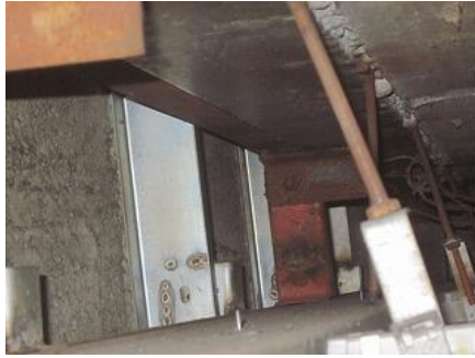
写真Ⅱ-17 カーテンウォール裏打ち断熱材
