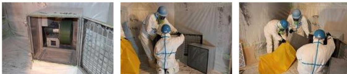
写真VI-10 HEPAフィルタの交換
