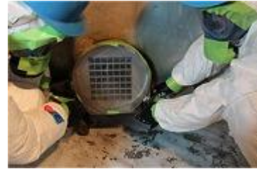
写真VI-4 集じん・排気装置の排気口をプラスチックシート等で封鎖
