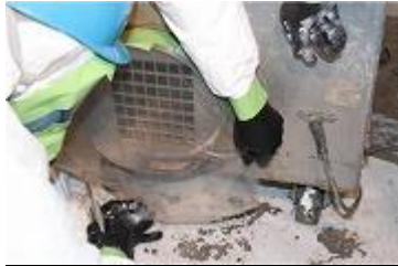
写真VI-4 集じん・排気装置の排気口をプラスチックシート等で封鎖
