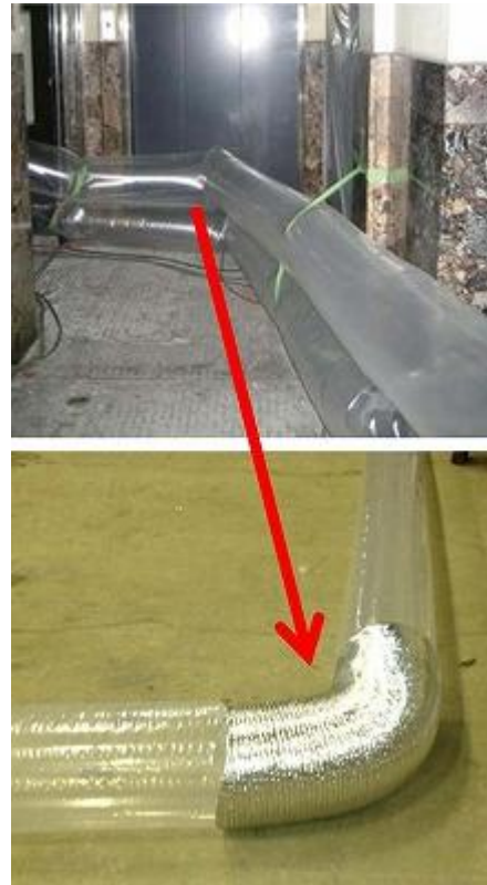
図-10 ビニールダクトの曲がり部分に環状の支え（アルミ製ダクト）をビニールダクトに重ねて使用した例
