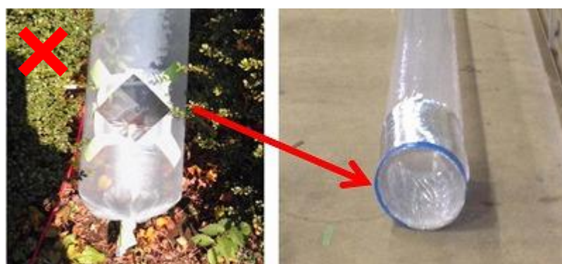
図-11 ビニールダクトの先端部分を環状の支え（アルミ製ダクト）を重ねて使用した例
