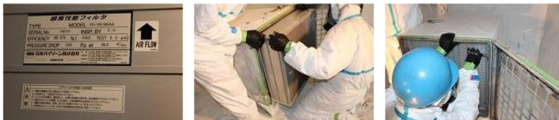
写真VI-11 フィルタの取り付け
