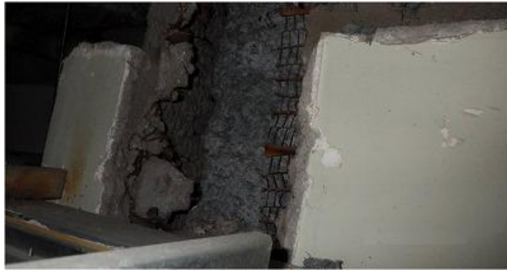
写真Ⅱ-13 壁の中に青石綿が吹かれラス網の上モルタル+プaster塗り仕上げ
