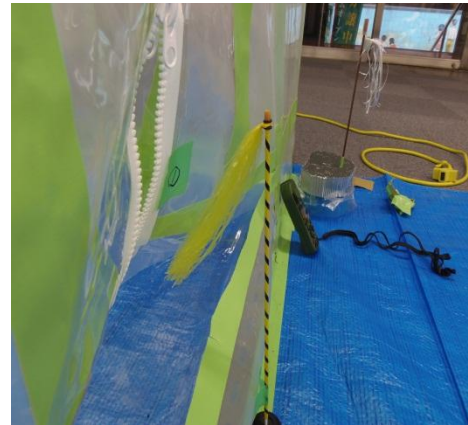
図-23 吹流しによる確認
