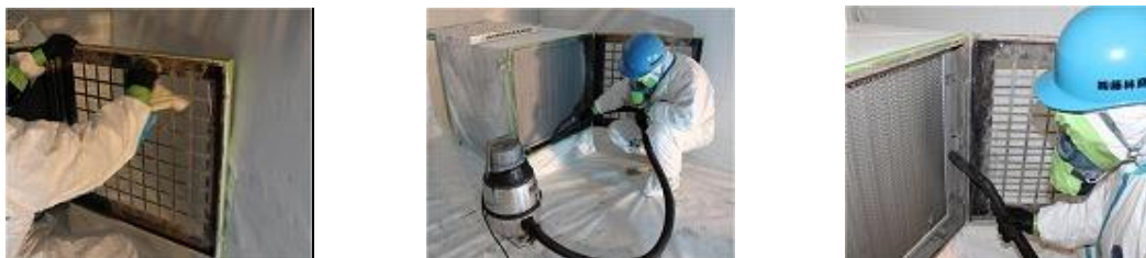
写真VI-8 HEPAフィルタ等の清掃
