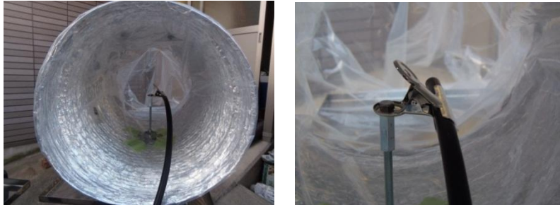
図-29 チューブ配管を使用した場合の排気ダクトの測定例
