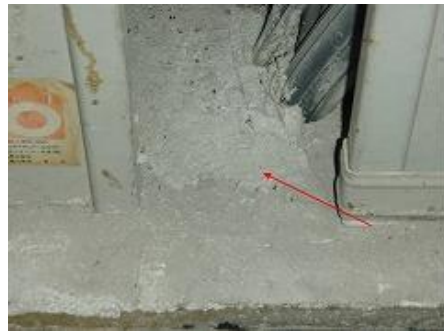
写真Ⅱ-12 電気配線部分隙間閉鎖
