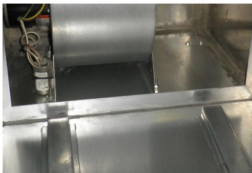
写真Ⅶ-5 コーキング処理
