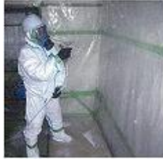
写真VI-2 養生シートへの散布
