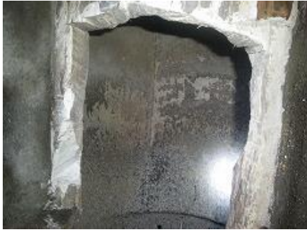
写真Ⅱ-9 ハイスタック煙突断熱材
