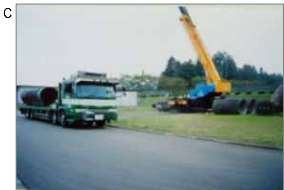
C この水道管の現在の撤去風景。振動により破損し、粉じんが飛散することがないように、丁寧に運搬する必要があります。
