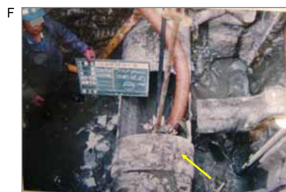
F 破損し水が溢れた石綿管の取替え工事。地盤沈下や重量物通過、あるいは災害で起こりえるシーンです。交換用石綿セメント管を寸法あわせのために現場で切断したため、その際にばく露した可能性があります。
