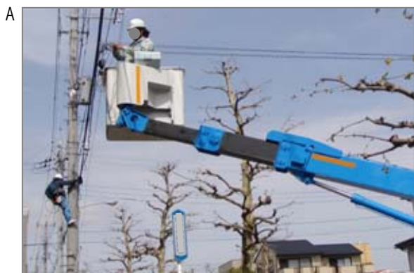
A 電気の使われ方は無限にあります。これは有線放送などの配線工事。これらの電線の切断、結合での作業では石綿ばく露は無い、と思われませんが切りカスに石綿紙が含まれている可能性などを認識しておくことは大事です。
