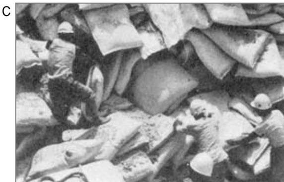
はしけ内の石綿荷役作業、通称「まくり返し」と呼ぶ乱雑な荷さばきで手鉤により破れた袋が多くありました。破れた箇所から石綿が飛散し、作業者がばく露した可能性があります。
