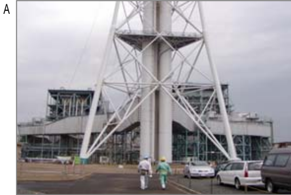
【概要】発電所には過去に多くの石綿が使用されました。現在でも耐火を目的とした建材、変電設備の防音材、発電設備の保温材・シール材、地中線用の石綿セメント管等に石綿が使用されている場合があります。解体時に石綿が飛散する可能性があります。非石綿製品への切り替えは計画的に相当以前から行われてきました。
