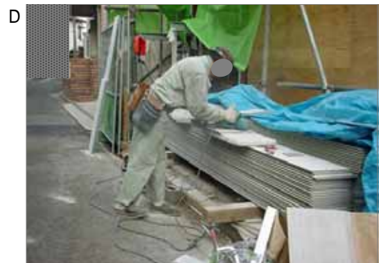
新築時の外壁の石綿含有サイディングを切断する作業です。1970年代は大工職がサイディングの切断をする事も多かったようです。
