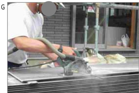
住宅の外壁サイディング張り工事。大工、屋根工、板金工なども施工します。屋外での現場合わせの切断ですから風向きによっては粉じんが遠くまで飛びます。粉じん発生量は非常に多いです。
