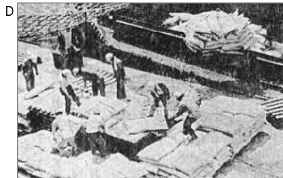
1978年。「はしけ」から陸揚げされた石綿をパレットに積み替える作業。このときも、手鉤を使用しています。
