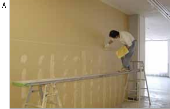
リフォームの主は壁紙の張替え(クロス工)。下地調整が最重要でパテ(目止め)で何回もしごきます。昔はこのパテに石綿混和材が、またごく一部ですが壁紙にも混入されていました。
