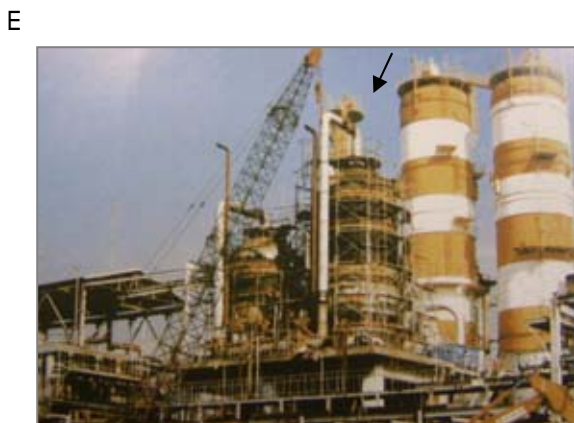
E 石油精製工場のプラント老朽化による解体工事。手順としては、石綿断熱材などの有害物質が飛散しないように、シートで覆った空間の中で撤去してから、重機で解体します。
