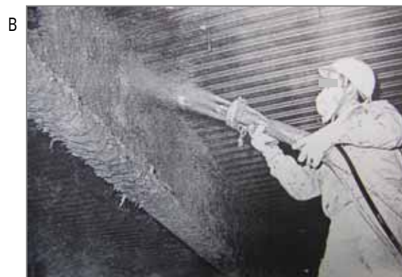
鉄骨の梁(はり)に耐火被覆として吹きつけているところです。この作業周辺は粉じんが舞っていて、作業者や周辺で作業をしていた者が高濃度ばく露した可能性があります。
