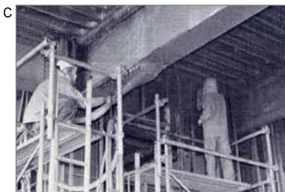
概ね3人1組の作業で吹きつけ者(左)、それを木製のコテで押え付ける者(右)、および調合綿を機械に投入する作業員からなっていました。どの作業も全身に石綿ばく露した可能性があります。
