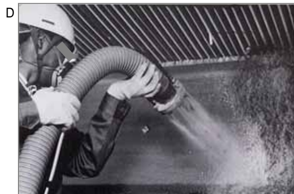
写真は最近の岩綿吹きつけ(石綿は含まれていません)。仕組みは昔と変わらずホースの中央より綿が出て、その周囲の数箇所のノズルより霧状に水の圧力で対象物に付着させます。昔と較べて粉じんは少ないです。
