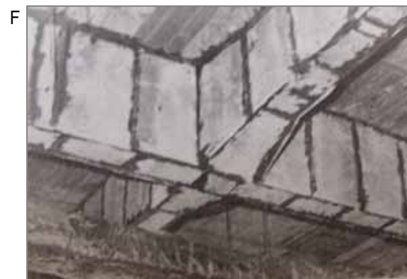
左の石綿耐火被覆板を梁に貼ったところ。釘・かすがい・接着剤(石綿入り)で施工しました。収まりを良くするために、現場で材料を形に合わせて切断することは必要な作業ですが、吹きつけ工法よりは粉じんの発生は少ないです。
