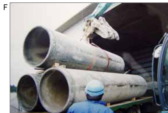
F 青石綿含有の使用済み水道管の現在の搬出風景。重量物ですので扱いが多少は手荒になることもあります。以前は現場で粉々に砕いて埋めており、その際に粉じんが舞ったと考えられます。
