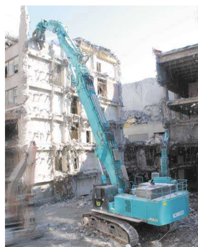
特定解体用機械のコンクリート圧砕機 コベルコ建機株式会社製、同社提供
