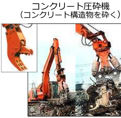
日立建機株式会社製、同社提供 (上写真右はコンクリート圧砕機(大割)・左は同(小割))
